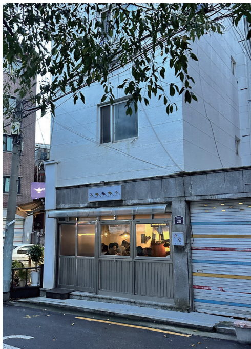
추랑 레트로한 느낌으로 리모델링한 1층 가게와 윗층의 대리석 질감의 외장재가 대비된다.
