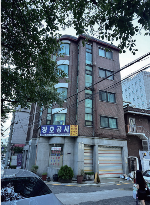
창호공사 상가로 사용하는 아래층과 주거용의 윗층 외장 재 재질이 서로 다르다.
