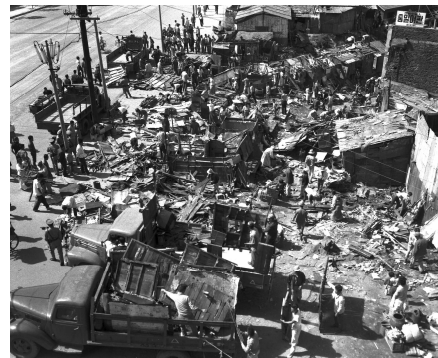
양동 무허가 건물 철거(1964. 9. 23.)
