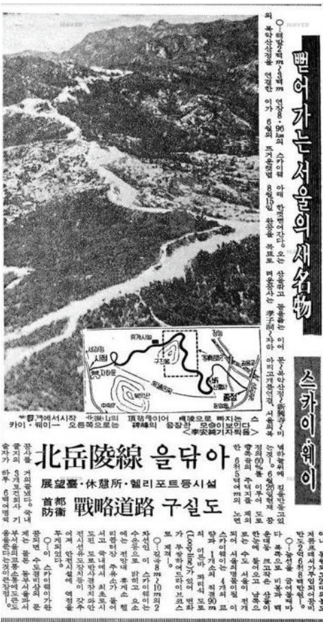
[그림44] 1968년 공사 중인 북악스카이웨이 (『경향신문』 1968. 6. 26.)
