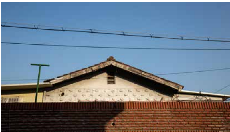
주택의 지붕과 외벽
