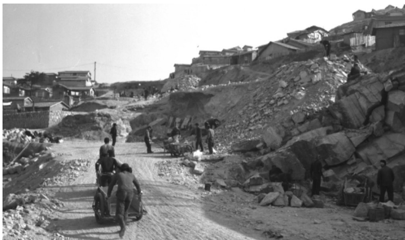
서울사진아카이브 금호동 1961년 한강주변 도로신설 공사
