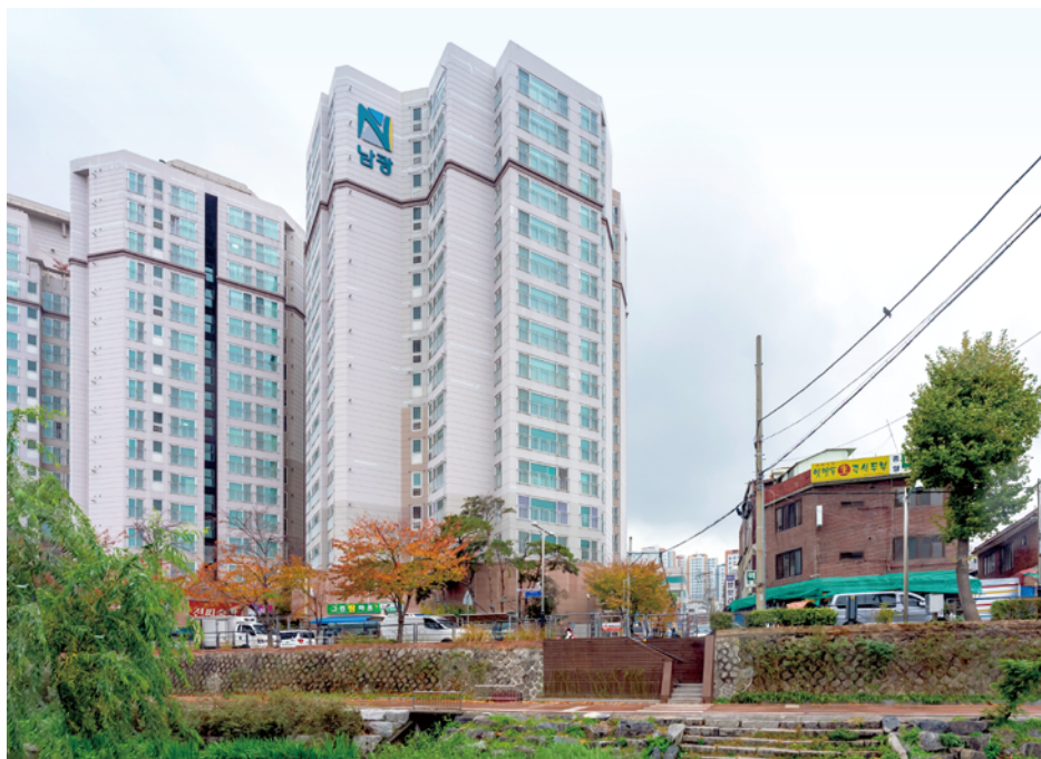
그림 64 보문시장자리에 건설된 보문 하우스토리아파트
