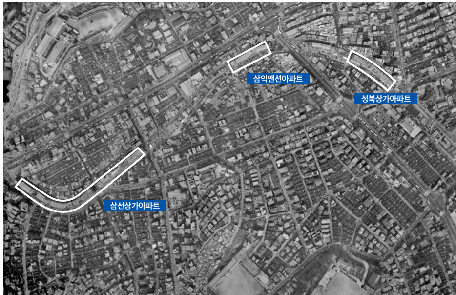
그림 47 1972년 항공사진에 보이는 완공 직후의 성북, 삼익, 삼선상가아파트(출처: 국토지리정보원)
