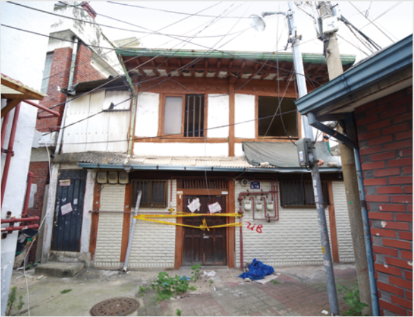
그림 44 내부 골목길에 위치한 2층 도시한옥상가 건물과 부정형의 골목길
