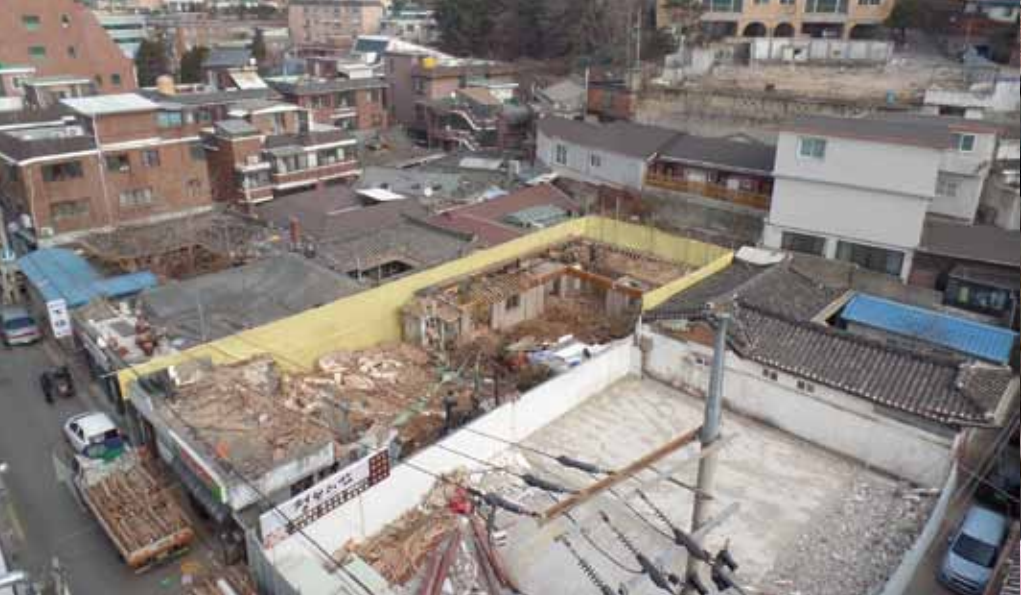
[사진 2] 상업과 주거가 혼용된 긴 필지 내에 멸실된 한옥
