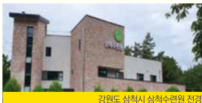
강원도 삼척시 삼척수련원 전경
