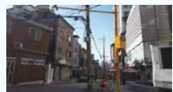
주택가 방범CCTV 설치
